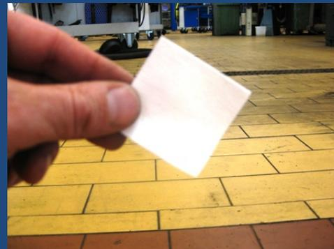
4. Reinigen Sie die Fläche mit dem mitgelieferten Gewebe und Lösungsmittel. Reinigen Sie die Fläche bis KEIN Schmutz mehr darauf ist.
